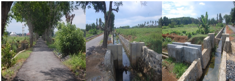
Gambar 39. Jalan, Saluran irigas dan pintu air
