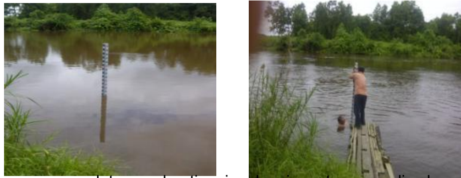
Gambar 5. Pemasangan alat pengukur tinggi muka air saat pasang di saluran
