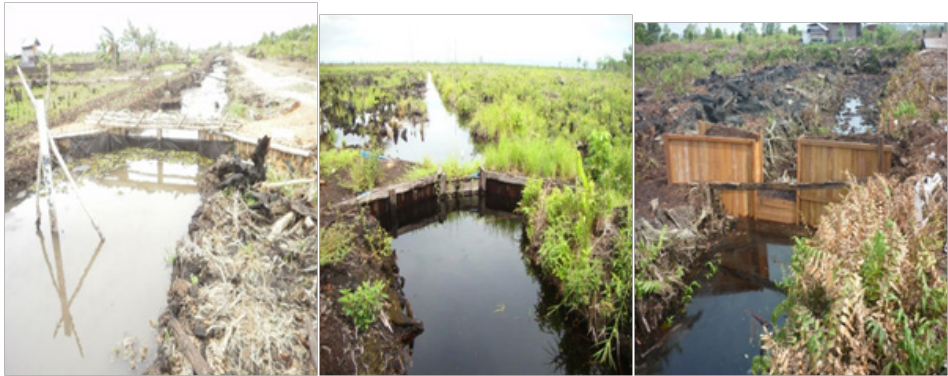
Gambar 7. Model tabat sederhana di lahan gambut Desa Hiyang Bana, Kabupaten Katingan, dan di Desa Jabiren, Kabupaten Pulang Pisau, Kalimantan Tengah, serta di Tegal Arum, Kota Banjarbaru, Kalimantan Selatan (Dok. M. Noor/Raihan/Balittra)
