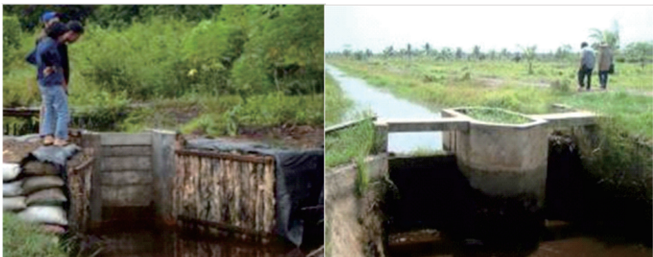
Gambar 7. Model tabat dari kayu dan beton
